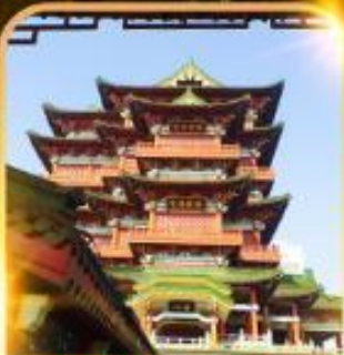
หอถึงหวิ่งเก๋อ
