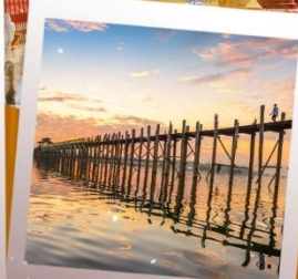
สะพานไม้จูปิง
